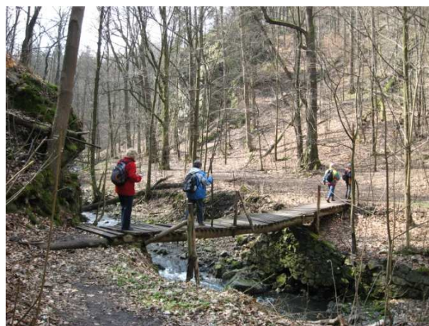
Pokonywanie zdezelowanego mostu nad Szczawnikiem w okolicach Pełcznicy. Wąwóz Szczawnika 5.04.2011r
