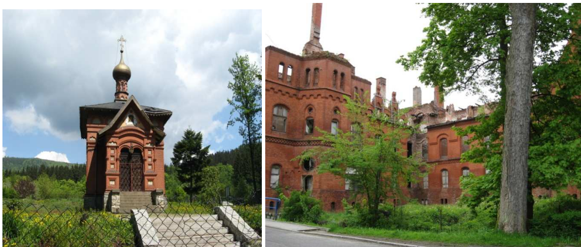
Cerkiew i niszczący Grunwald w Sokołowsku.
